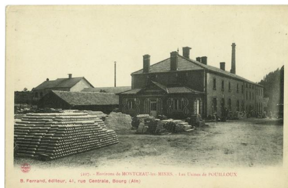
usine de Pont des Vernes, Pouilloux
