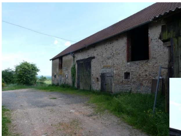
Vue d'ensemble de la longère (espaces ouverts peu favorables aux chiroptères)
