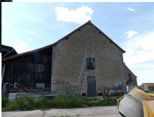
Façade est (quelques anfractuosités favorables au Moineau domestique)
