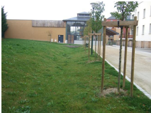
Noue engazonnée végétalisée
