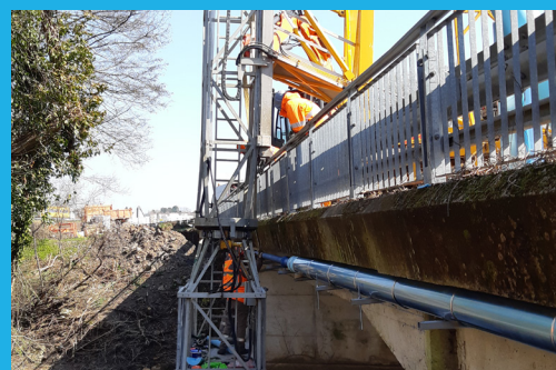
Travaux de pose d'une conduite d'eau potable sous un pont.
