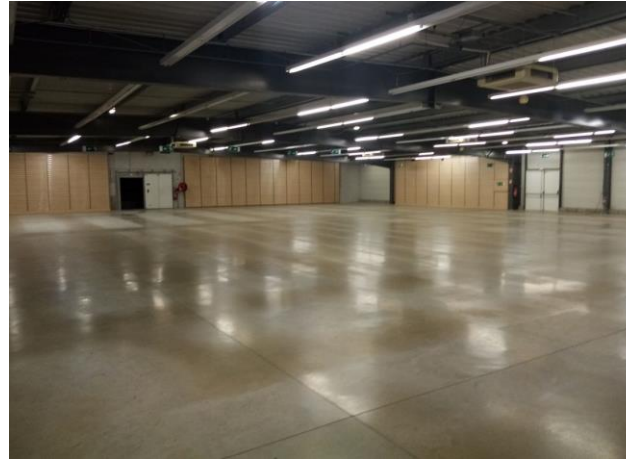
Figure 23 Intérieur du bâtiment recyclerie (CUCM)
