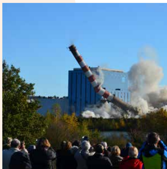
Démolition cheminée © Lionel Janin-JSL
