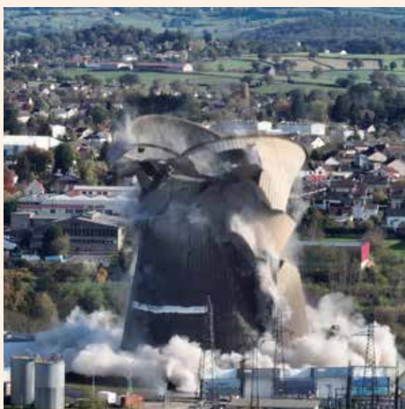
Démolition tour Lucy © France 3 Bourgogne-France-Comté
