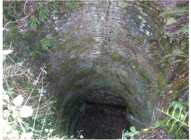
Photo 12 : Puits des Mésarmes. Puits ouvert et accessible.
