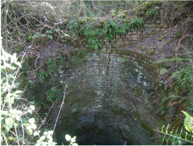
Photo 11 : Tête du Puits des Mésarmes, parement en brique, fissuré.
