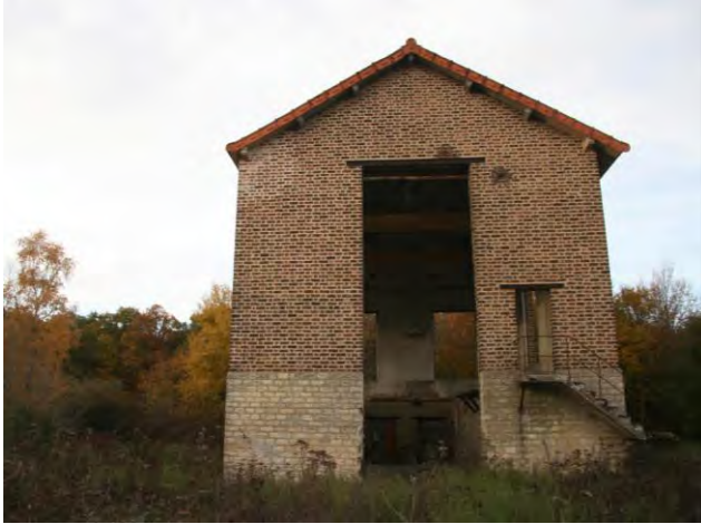
Photo 8 : Bâtiment à proximité du puits Sainte Barbe de Montchanin.
