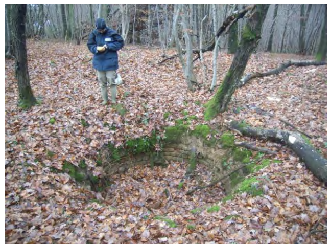
Photo 22 : Puits Montaignu n°1. Puits remblayé ayant débouillé.
