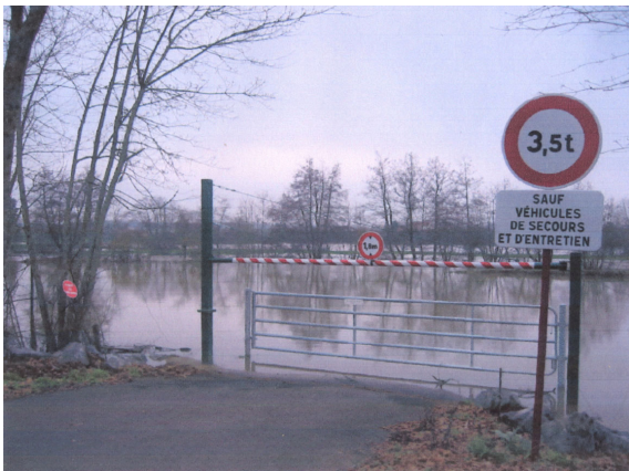
11- Crue de janvier 2004 à Ciry-le-Noble Barrage des Touillards
