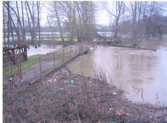
12- Crue de janvier 2004 à Ciry-le-Noble Barrage des Touillards
