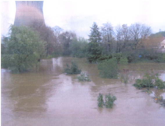
7- Crue de novembre 2004 à Montceau-les-Mines Quai des Moulins – Centrale Thermique
