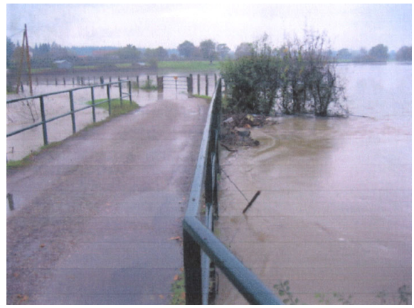
8- Crue de novembre 2004 à Montceau-les-Mines Pont du Bois Perrault
