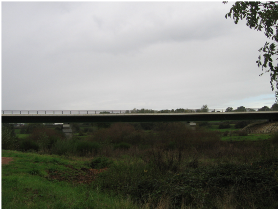
3- Nouvel ouvrage sur la Bourbince
