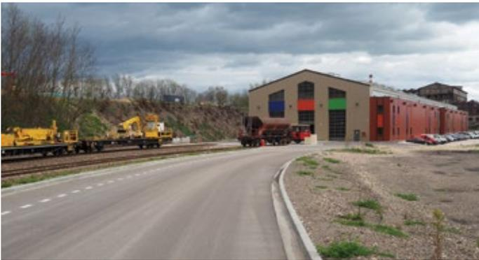
Long de 110 mètres, large de 30 mètres et haut de 10 mètres, le bâtiment de l'immense halle de maintenance des engins ferroviaires est devenu opérationnel en 2018.
