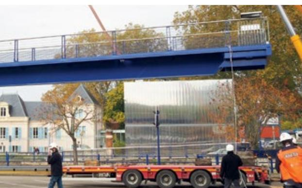
**MOBILITÉ** Suspendue à plusieurs mètres du sol par une immense grue installée sur le parking Mazuez à Montceau, la passerelle piétonne de 14 tonnes a retrouvé son emplacement, au-dessus du canal du Centre. Réalisée par la communauté urbaine durant la deuxième quinzaine d'octobre, cette opération a fait suite à la révision de sa structure et à la réparation d'un des deux vérins chargés de la hisser lors du passage des bateaux.
