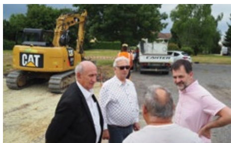
La commune installe des structures sportives au quartier des Gautherets.
