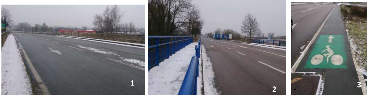
A Montceau-les-Mines, la traversée de la RCEA en direction de Sanvignes-les-Mines (1) est peu sécurisée. D'autres traversées, à l'image de la D57, vers le Val de Saône intègrent une sécurisation des déplacements piétons (2) et cyclables (3), via l'aménagement d'un trottoir partagé.
