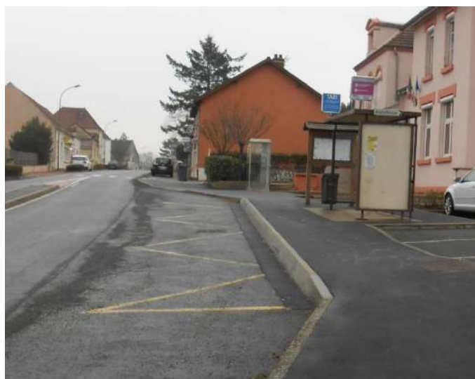
L'arrêt Montchanin-le-Haut situé à Saint-Eusèbe répondant aux normes d'accessibilité.
